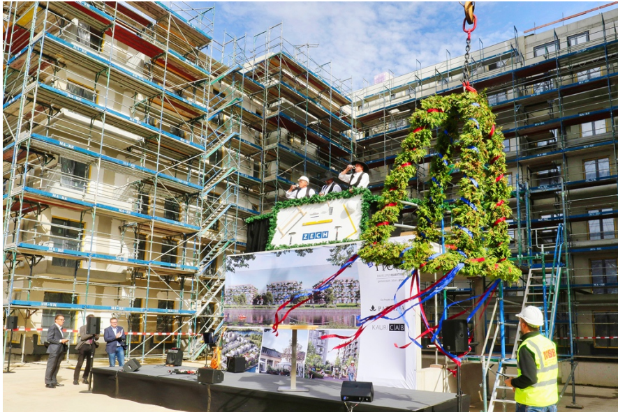
Hissen des Richtkranzes für das Havelufer Quartier (© KAURI CAB / PATRIZIA)
